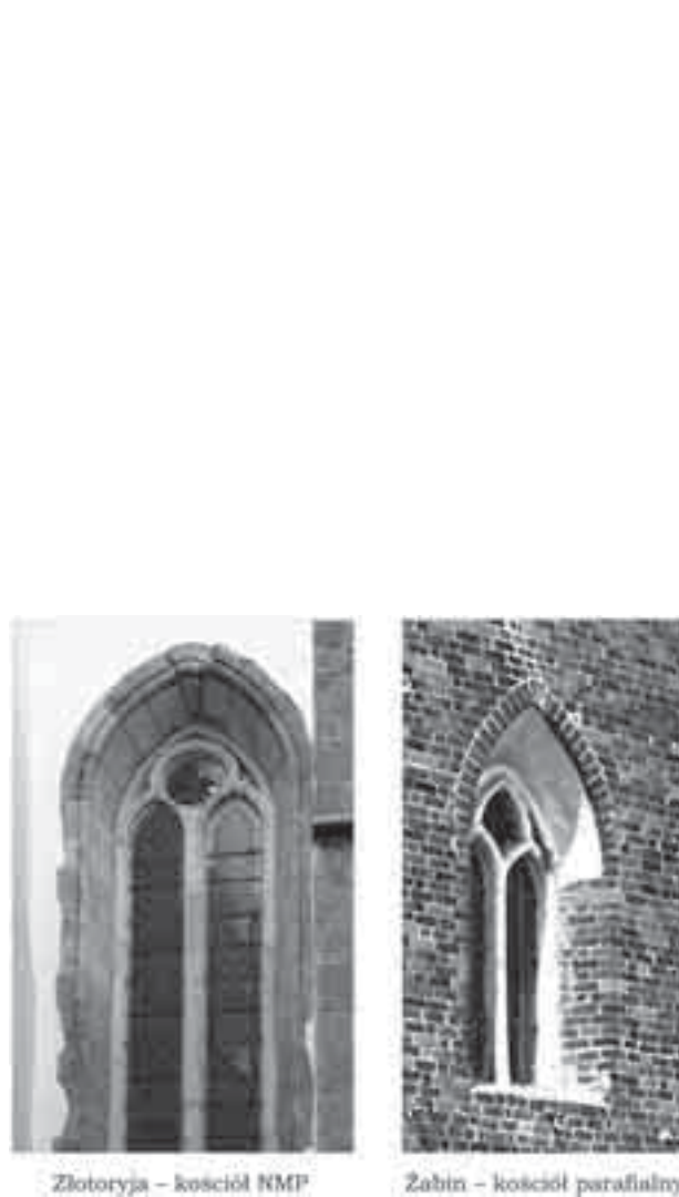
Il. 5. Okna maswerkowe z 1–2 ćwierci XIII w.
