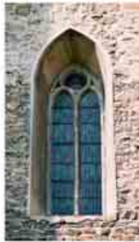
Pożarzyno – kościół parafialny, okno południowe, okno wschodnie prezbiterium
